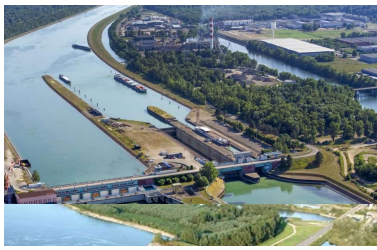
Centrale hydraulique Strasbourg
