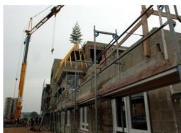
Une grue a hissé hier matin le sapin qui marque l'achèvement de la charpente sur la future résidence « Les Trois Fleurs » à Holtzheim. (Photo DNA - Laurent Réa)
